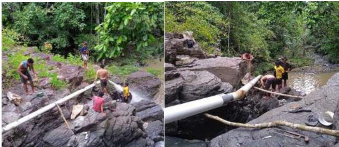
Gambar 5. Pemasangan Instalasi Pipa
