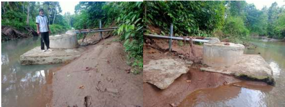
Gambar 2. Sumur Buatan Sumber Air Desa Toniku
