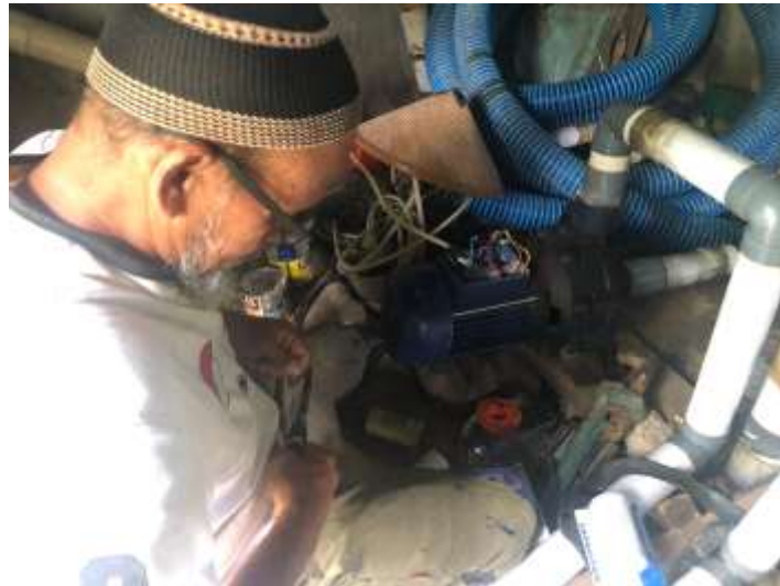
Gambar 7. Pergantian Kapasitor Pompa
