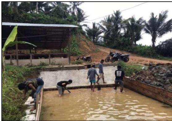
Gambar 4.6 Pembuatan Kolam *Sediment Pond*
