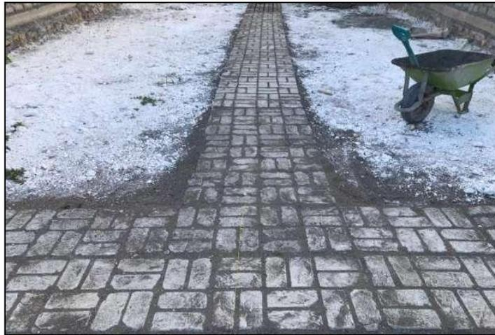
Gambar 4.13 Pembuatan Jalan dengan *Paving Block*
