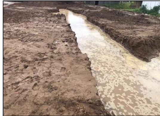
Gambar 4.7 Pembuatan Saluran *Drainage*
