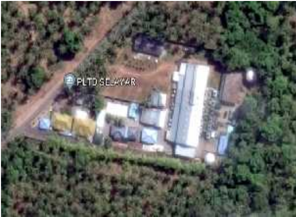
Gambar 2. Lokasi PLTD Selayar
