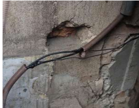
Gambar 3. Sambung Langsung Ke Kabel JTL
