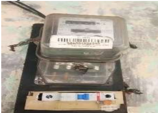
Gambar 2. kWh Meter Yang Disadap Dengan Menggunakan Kabel Jumper
