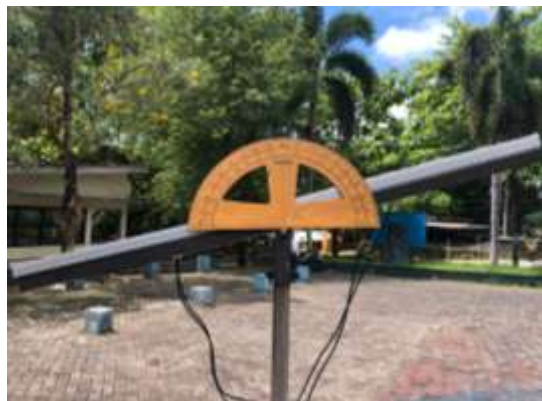
Gambar 6. Pengukuran Sudut Kemiringan Panel Surya
